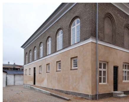
Tv: Selv om husene fra begyndelsen af 1800-tallet ofte er pudsede og kalkede, har mange facader fine skygge- og reliefvirkninger fx murede hjørnekvadre og fine profilerede gesimser. Foto: Torben Lindegaard.
