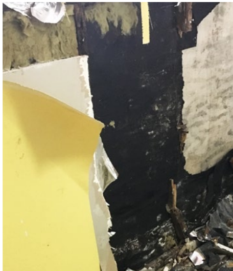
Her ser man de blottede lag. Til højre muren som ligger bagerst. Så er der et træskelet af lægter til at holde isolering og dampspærre.
