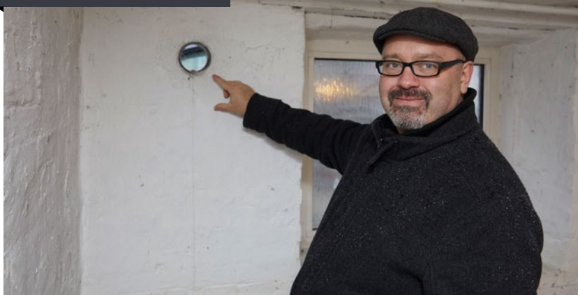
Bo Lauritzen påpeger, at denne ventilationsåbning til kælderrummene bør forsynes med en rottespærre. I skrivende stund er der fri adgang!
