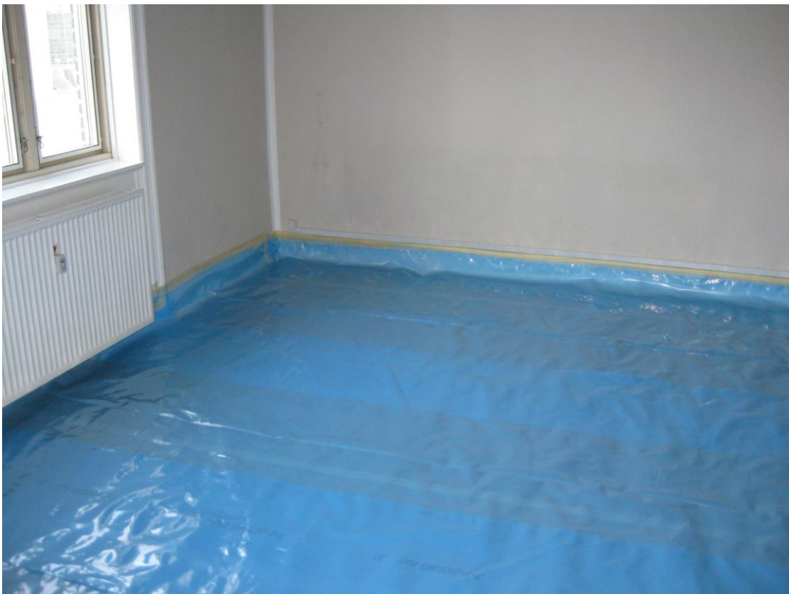
Foto 2: På gulvpap/filt udlægges dampspærre, som trækkes op over fodpanel
