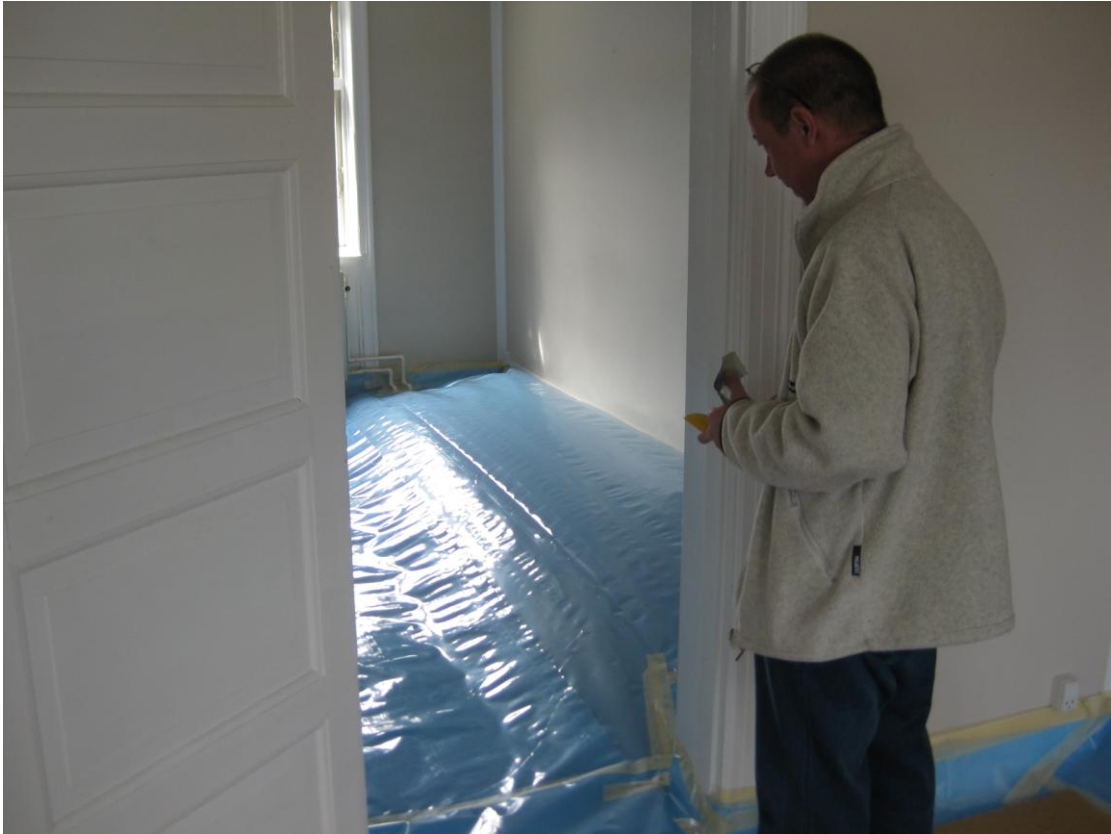
Foto 7: Dampspærre uden ballastplader i værelse løfter sig ved 50 Pa undertryk
