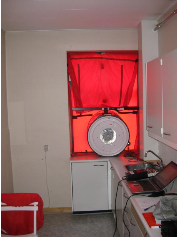
Foto 5: Blowerdoor monteret i det åbne køkkenvindue
