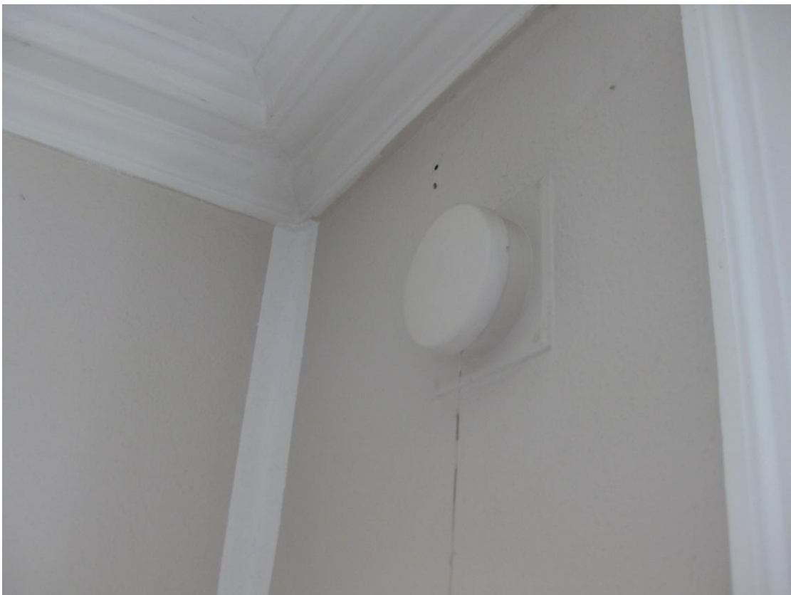
Foto 6: Friskluftventiler i væggen i begge stuer lukkes
