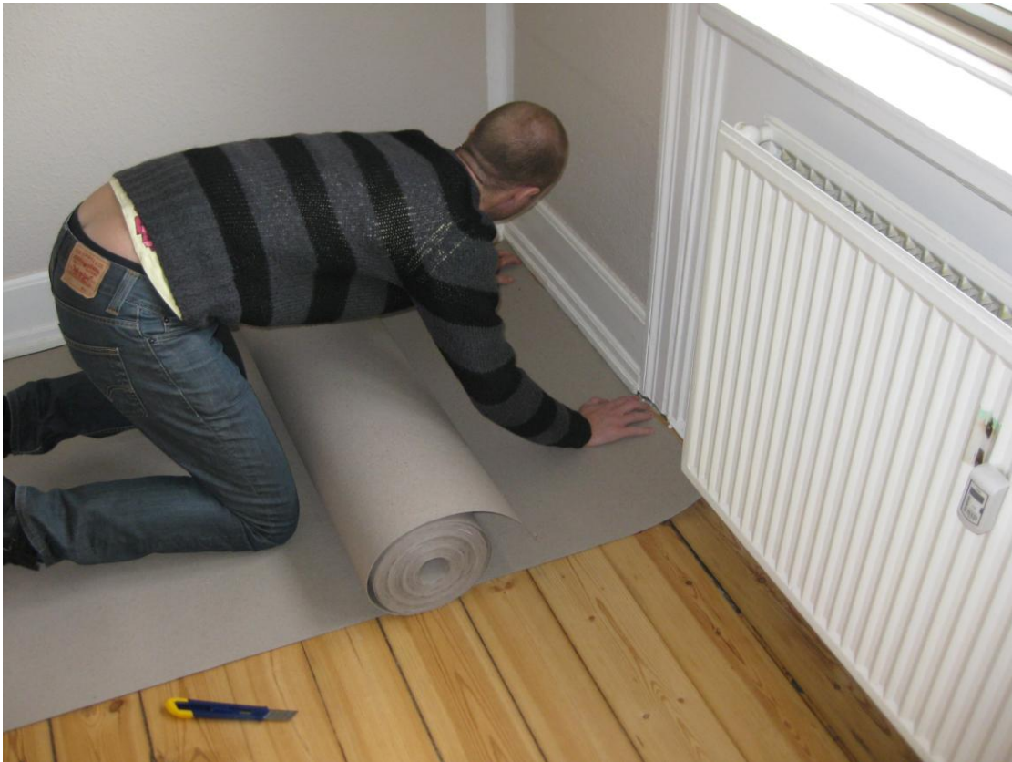
Foto 1: Kraftig gulvpap/filt udlægges til fejelisten på det blottede trægulv
