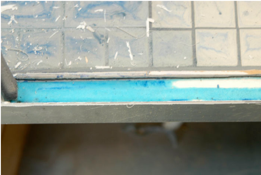
Figur 11. Skinne i gulv som underlag for vægelement.
