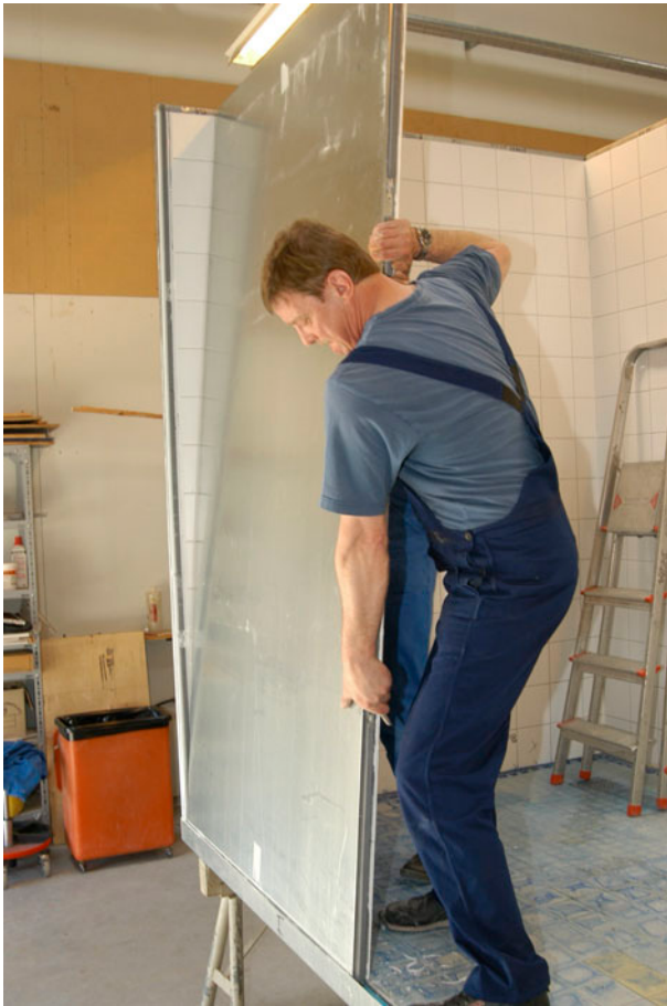
Figur 10. Montering af væg. Væggen monteres i en skinne langs gulvelements kant.
