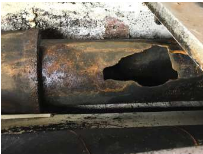
Figur 6.6. Faldstammer med større huller og gennemtæringer kan være vanskelige at rense
