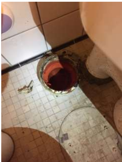
Figur 2.6. Toiletafløb behandlet med coating under 1mm
