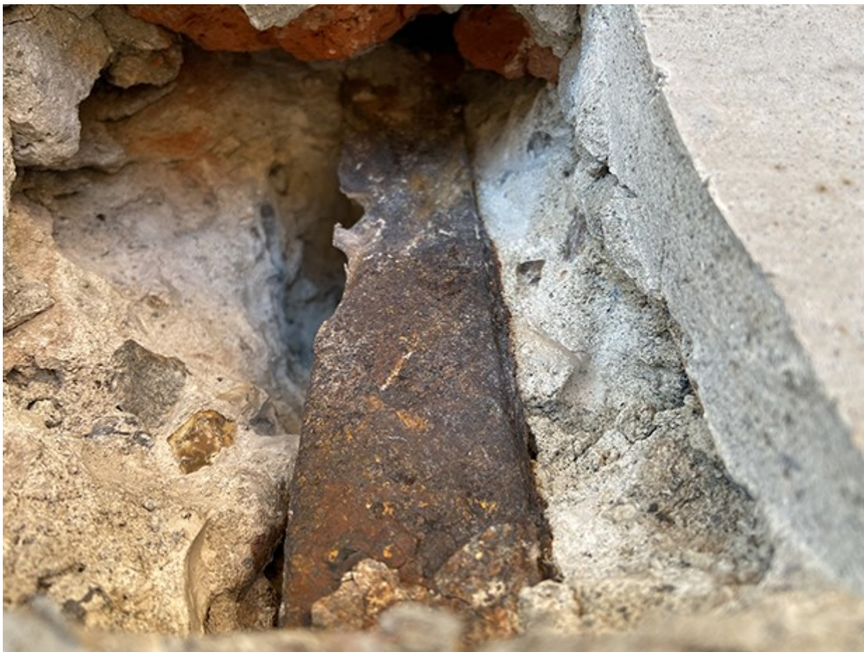
Foto 6-7. Udliggerjern, hvor det ses, at overflangen er med betydelig tværsnitsreduktion i den venstre side.
