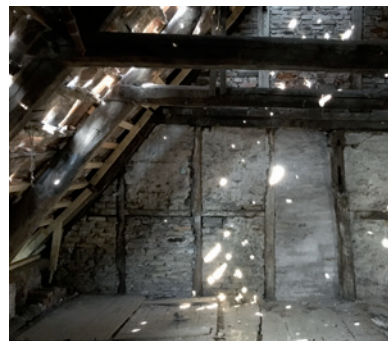
Et tag skal være tæt, så der ikke kan trænge vand ind. Du kan tjekke en bygnings tegltag, når solen skinner. Hvis du kan se sollyset gennem taget, er det ikke tæt.
