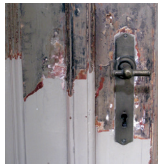
Genstande af jern har en god modstandsevne i forhold til brand. Her har dørgreb og langskilt overlevet en brand og er blevet rensset for sod.
