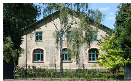
Villaen fra 1860 er fredet og restaureret: Murværket er omfuguet med brændte fuger, og den oprindelige farvesætning er genskabt i samarbejde med myndighederne.
