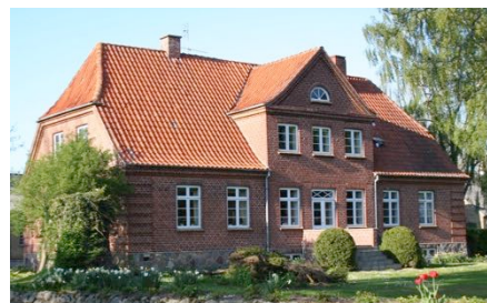
Tagbeklædningen er udskiftet med samme materiale som før og med samme håndværksmetoder fx murede rygninger.
