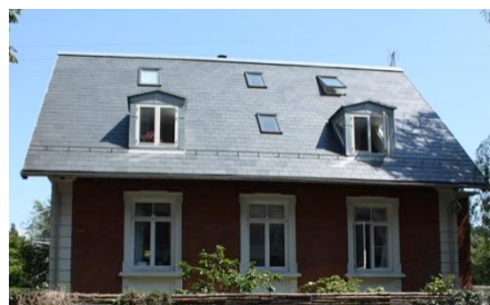
Huset er renoveret i forbindelse med en efterisolering af tagetagen. De nye utilpassede kviste og tagvinduer er ikke i tråd med arkitekturen.
