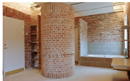
Transformation af gammel svinestald til hotelværelser. Der blev brugt genbrugssten på nye vægge for ikke at gøre overfladerne for fine.
