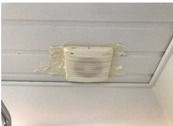
Aftræk lukket med tape
