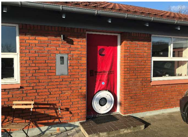
Blowerdoor set ude fra
