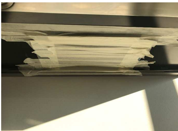
Emhætte lukket med tape
