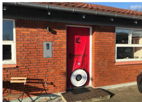
Blowerdoor set udefra.
