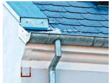
Her ses den nye tagbeklædning, isoleringstykkelser ved gesimsen er markeret.
