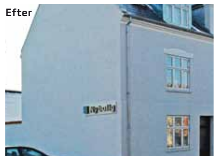
Gavlen er nu udvendigt isoleret med pudsede mineraluldsbatts.
