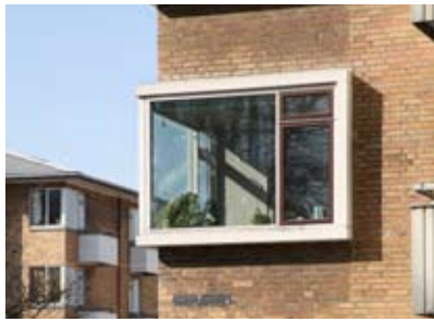
De elegante udkragede vinduer er udført uden understøtning i hjørnet.
