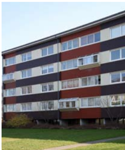
Facaden er totalrenoveret, og altanerne er lukkede med glasruder:
