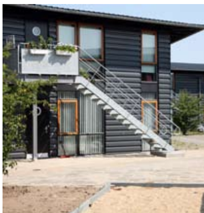
Fem Fingre/Fagbo, Ladefogedvej 2-84, Skejby (1993, 2000 af Tegnestuen Vandkunsten) Tag- og facadebeklædning er udført med lakerede, profilerede stålplader.
