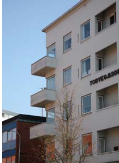
Facadens kubistiske udtryk med både udkragede altaner og indbyggede altaner understøttes af de ensartede overflader og den enkle detaljering.
