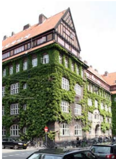
Gothersgade/Vognmagergade/Lønporten, København (1912-13 af G.B. Hagen & Rolf Schroeder): Den store murede bygningskrop afsluttes med en tagkonstruktion udført i bindingsværk.
