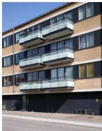
Facaderenoveringen er tilpasset det oprindelige udtryk.
