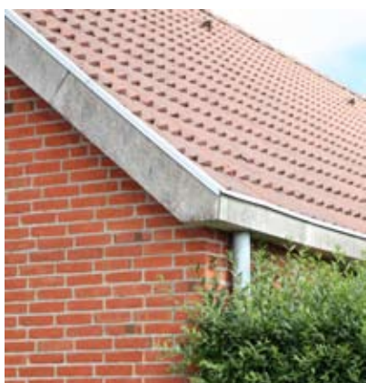
Patinerung. Cementtagstenene afbleges, eternitsternen bliver gråsort, plasticnedløbsrøret bliver blankt.
