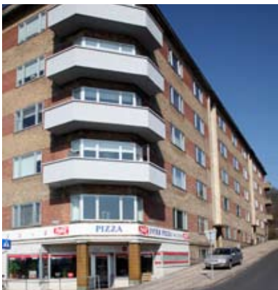
De stoflige kvaliteter forsvinder, når altanernes indfarvede pudslader malerbehandles, eller når altaner indpakkes i profilerede stål-plader.
