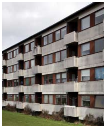
Den oprindelige facade er bevaret; betonfladerne giver bygningen en rustik stoflighed. De åbne altaner vitaliserer facaden.
