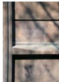
Nærbillede af en facadereparation med indfarvet mørtel.
