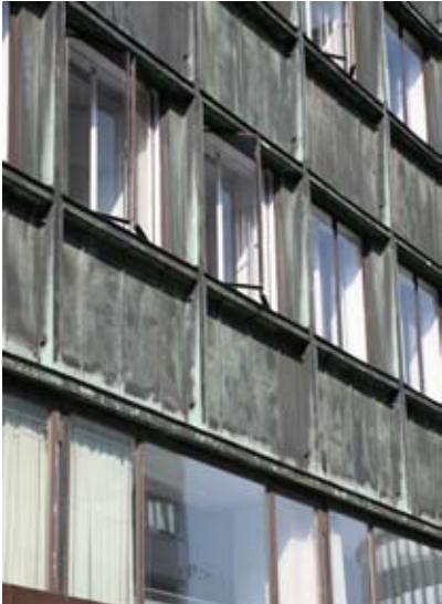
Den gennemførte kobberbeklædte facade fremstår ensartet med en stofflig helhedsvirkning. De slanke vinduesprofiler giver facaden et raffineret udtryk.
