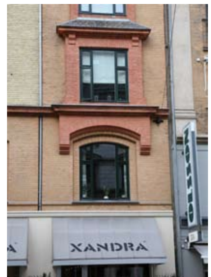
Murværket på den identiske nabobygning er nænsomt afrenset.
