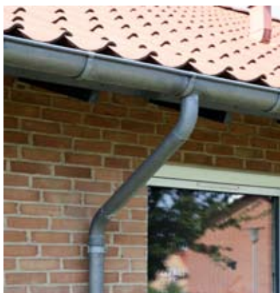
Patinerung. Cementtagstenene afbleges, eternitsternen bliver gråsort, plasticnedløbsrøret bliver blankt.
