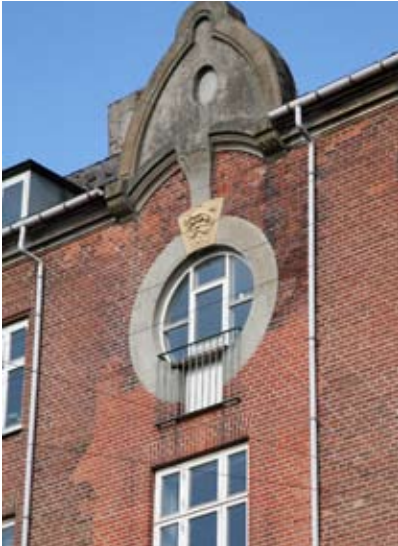
Ingerslevsgade, København (1908 af J.P. Rasmussen). Facaden har fået sløjfet en karnap og tilhørende altan. Det runde vindue er karnappens eneste rest.
