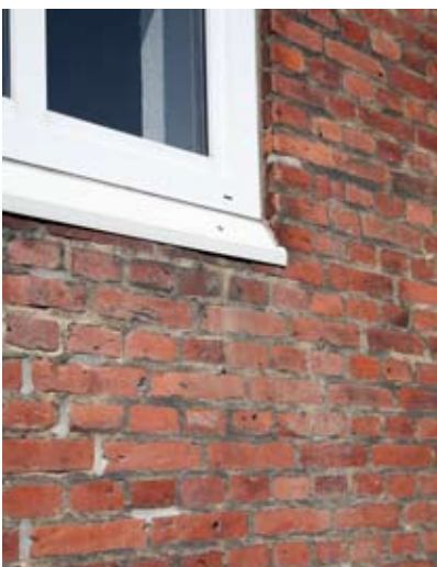
Aluminiumsålbenke er fremmede for stilen..
