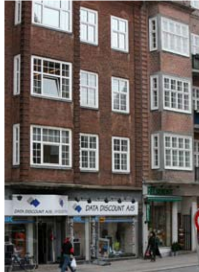
Flade plasticprofiler og sprosler inde i ruden - materialet er fremmed med ringe stoflighed og slap reliefvirkning.
