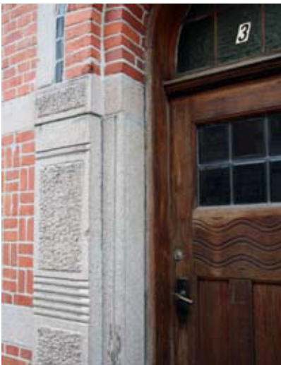
Dørindramning med mønstermurværk og fint tilhugget granit.
