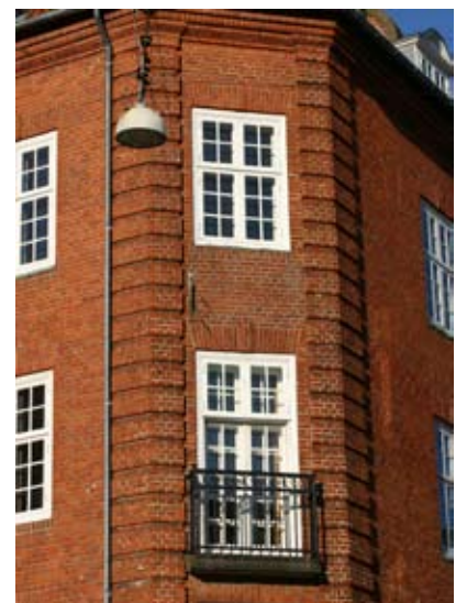
Fine proportioner og elegant kontrast mellem spinke sprosser og brede profilerede rammer:
