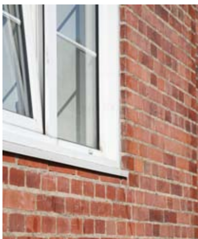
Et dårligt eksempel; plastikprofilerne er brede og skæmmende, sprosserne er indbygget i glasset og materialet er fremmed for bygningen.
