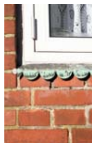
Trævinduer med sålbænke af kobber eller glaserede tegl - gode eksempler:
