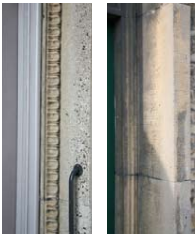
Et dårligt eksempel; plastikprofilerne er brede og skæmmende, sprosserne er indbygget i glasset og materialet er fremmed for bygningen.
