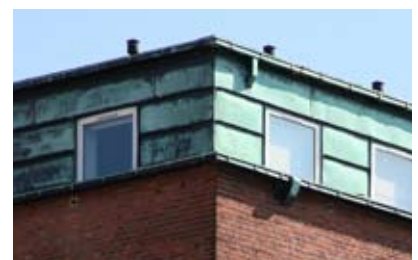
Tagnedløb føres ind i muren.
