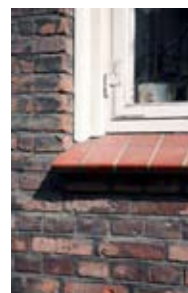
Trævinduer med sålbænke af kobber eller glaserede tegl - gode eksempler:
