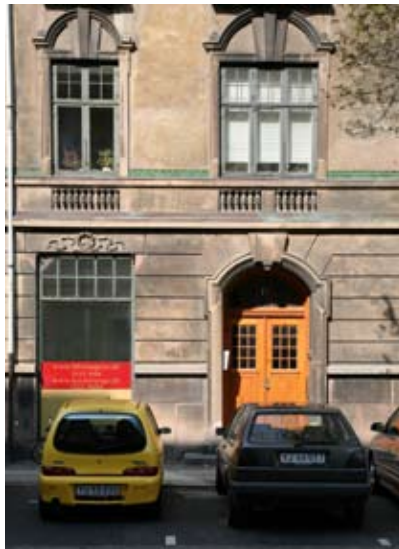
Facaden er oprindeligt oppudset med indfarvet mørtel. Den er repareret flere gange i tidens løb med indfarvet mørtel og fremstår med en karakterfuld patinering.
